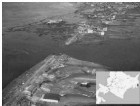
図10.2 1960年チリ津波による盛土堤防の決壊の様子（北海道厚岸郡浜中町）
