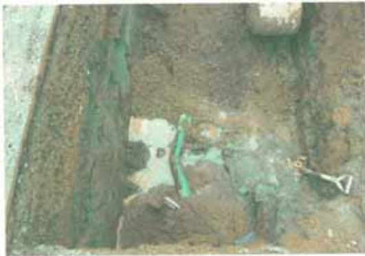
写真6.1 ガス導管の被害状況 1)
