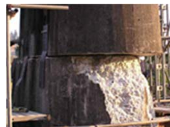
写真11.1 2004年新潟県中越地震で被災した魚野川橋梁14P橋脚 4)
