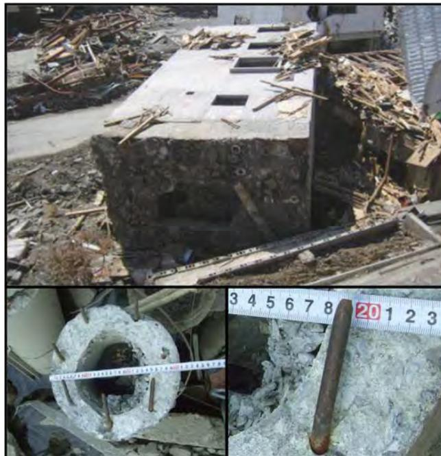
写真 10.2 対象構造物の被災後の様子（出典）土木学会地震工学委員会（2011）<sup>3)</sup>
